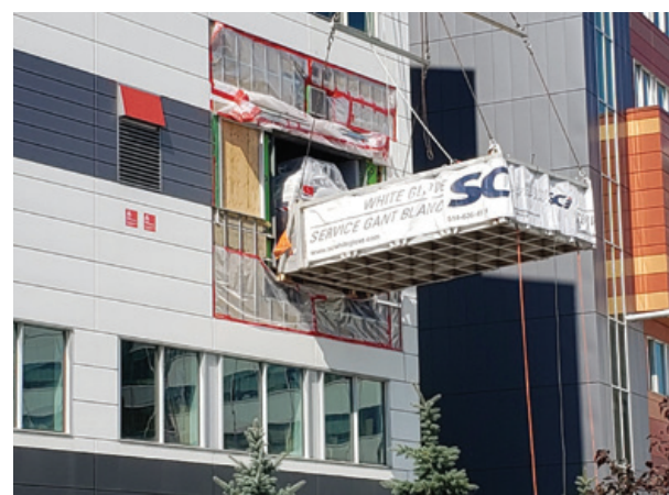
Livraison du nouvel appareil de RM cardiaque de pointe au site Glen
